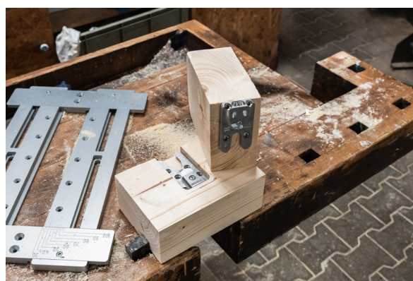
Fraisage et montage à l'aide d'un seul gabarit
