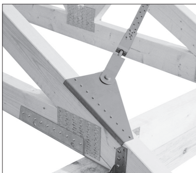
Détails sur le point de profilé inférieur: Raccord à bande BNF avec tendeur BNSPxxB.
