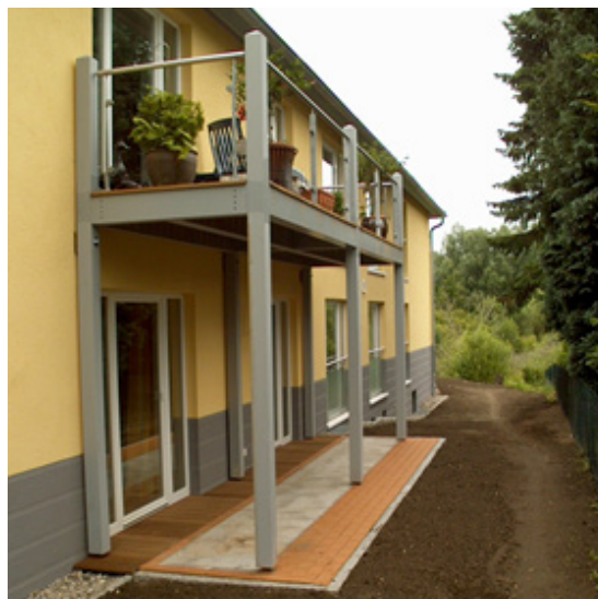
Installation de type balcon avec revêtement ouvert de la classe d'utilisation 3
