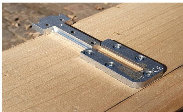
Image 3 La deuxième partie du connecteur ne peut plus être insérée, des retouches sont nécessaires
