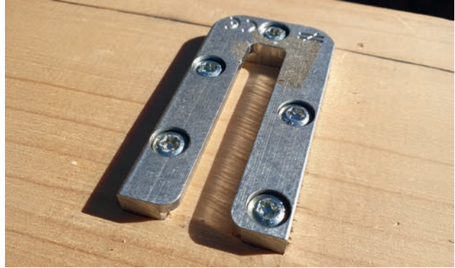
Bild 1 Verschraubung eines Verbinderbauteils ohne Drehmomenteinstellung. Der Verbinder drückt sich ins Holz ein
