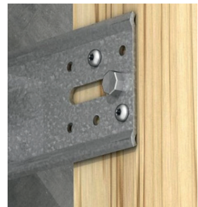
Eine Sechskantschraube Ø8mm und zwei Schrauben 5,0×ℓ als Verdrehsicherung
