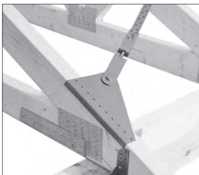
Detail am Traufpunkt: Bandanschluss BNF mit Spanngerät BNSPxxB.
