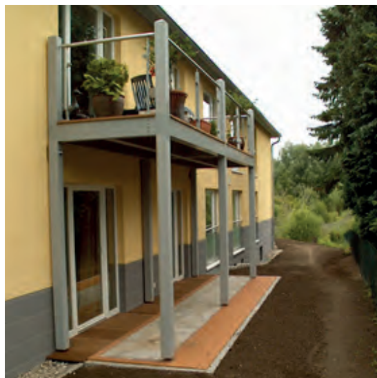
Balkonanlage mit offenem Belag in Nutzungsklasse 3
