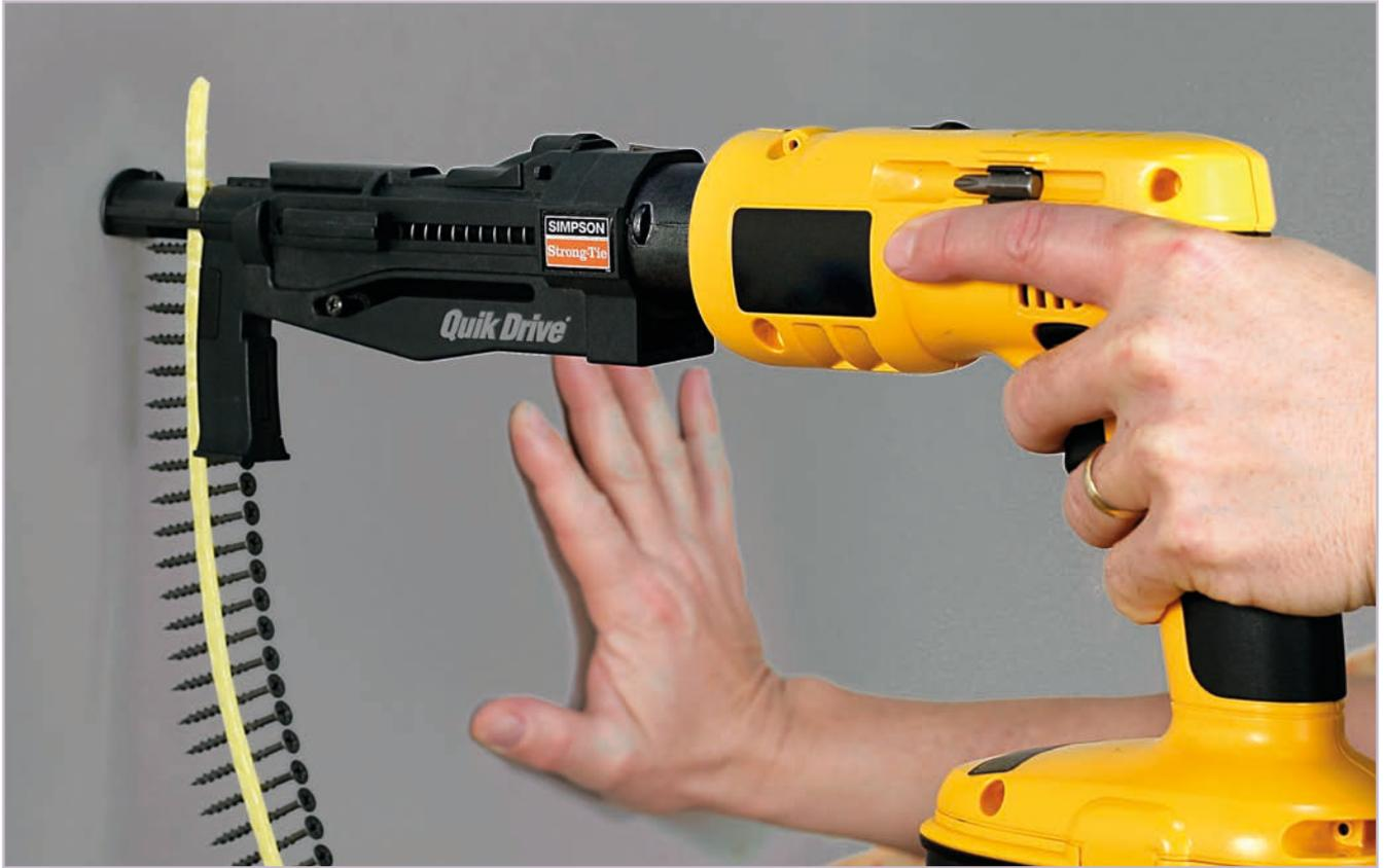
Montage einer Gipskartonplatte an Holzständerwerk mit DWC-Schnellbauschrauben
