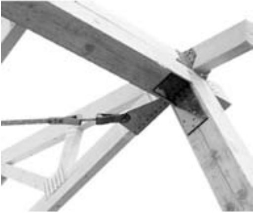
Detail am Traufpunkt: Bandanschluss F25 mit Spanngerät B25 Ø12 auf der Unterseite des Sparrens befestigt. Holzbreite: mind. 45 mm
