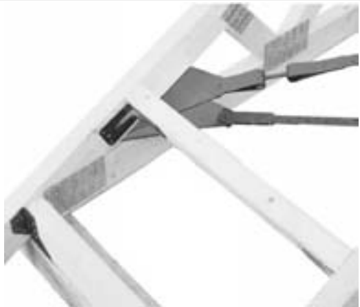
Detail am Traufpunkt: Bandanschluss G25 mit Kopplungsverbinder 25 und Spanngerät B 25 Ø12. Die Wechselbalken dienen als Druckhölzer.
