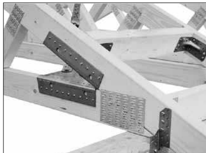
Detail am Traufpunkt: Bandanschlüsse BNG25 an Ober- und Untergurt eines Nagelplattenbinders befestigt.
