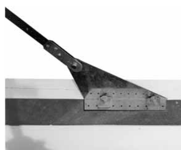
Detail am Fundament: Bandanschluss G25 auf Beton verbolzt. Lastverteilung durch die U-Scheibe 40 x 50 x 10.
